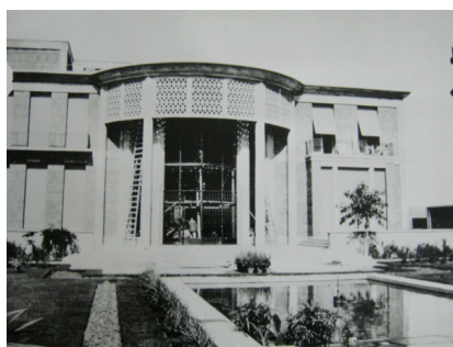
Villa Aghion, vue de la façade sur jardin encore en travaux, non daté. (Archives © IFA, 535 AP 655 / 4)
