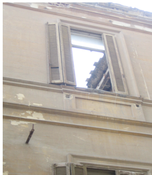
Villa Ambron, vue de la toiture, état janvier 2008. (Cl. C. Daridan)
